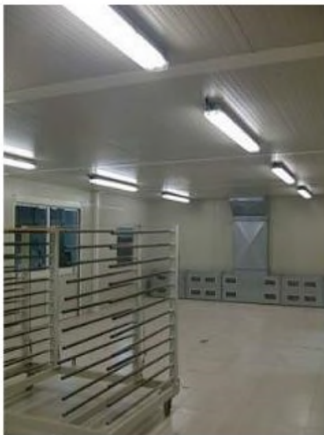
Dossieret d'aspiration par ventilateurs centrifuges
